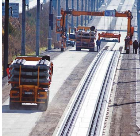
Abb. 2: JIS Anlieferung beim Einbau von Feste Fahrbahn Elementen
