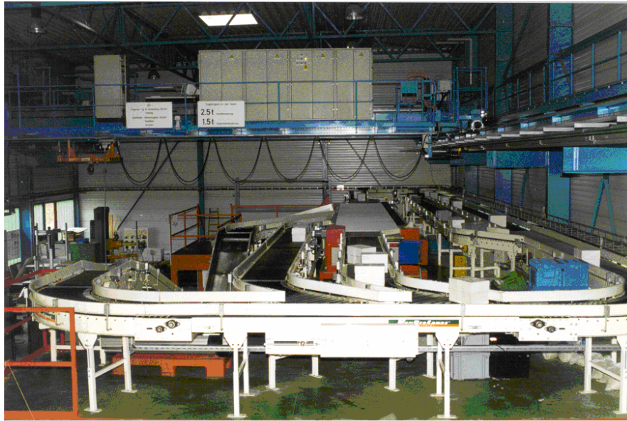
Abb. 1: Blick auf die obere Ebene der Versuchsanlage
